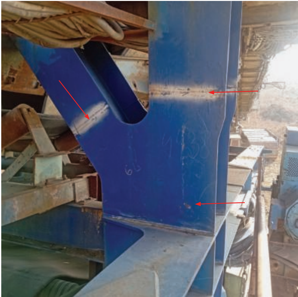
8. ábra. Fő tartógerenda telepítése vágótöltettel (a szerzők felvétele)
