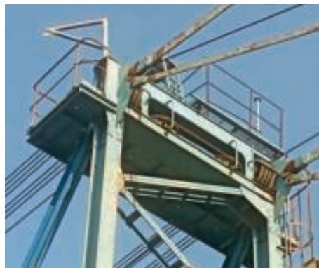
10. ábra. Elektromos kapcsolóház és ellensúlytartó pántok (a szerzők felvétele)
