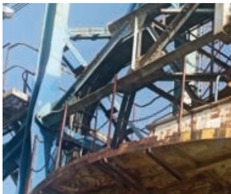
9. ábra. Elektromos kapcsolóház és ellensúlytartó gerenda telepítése (a szerzők felvétele)
